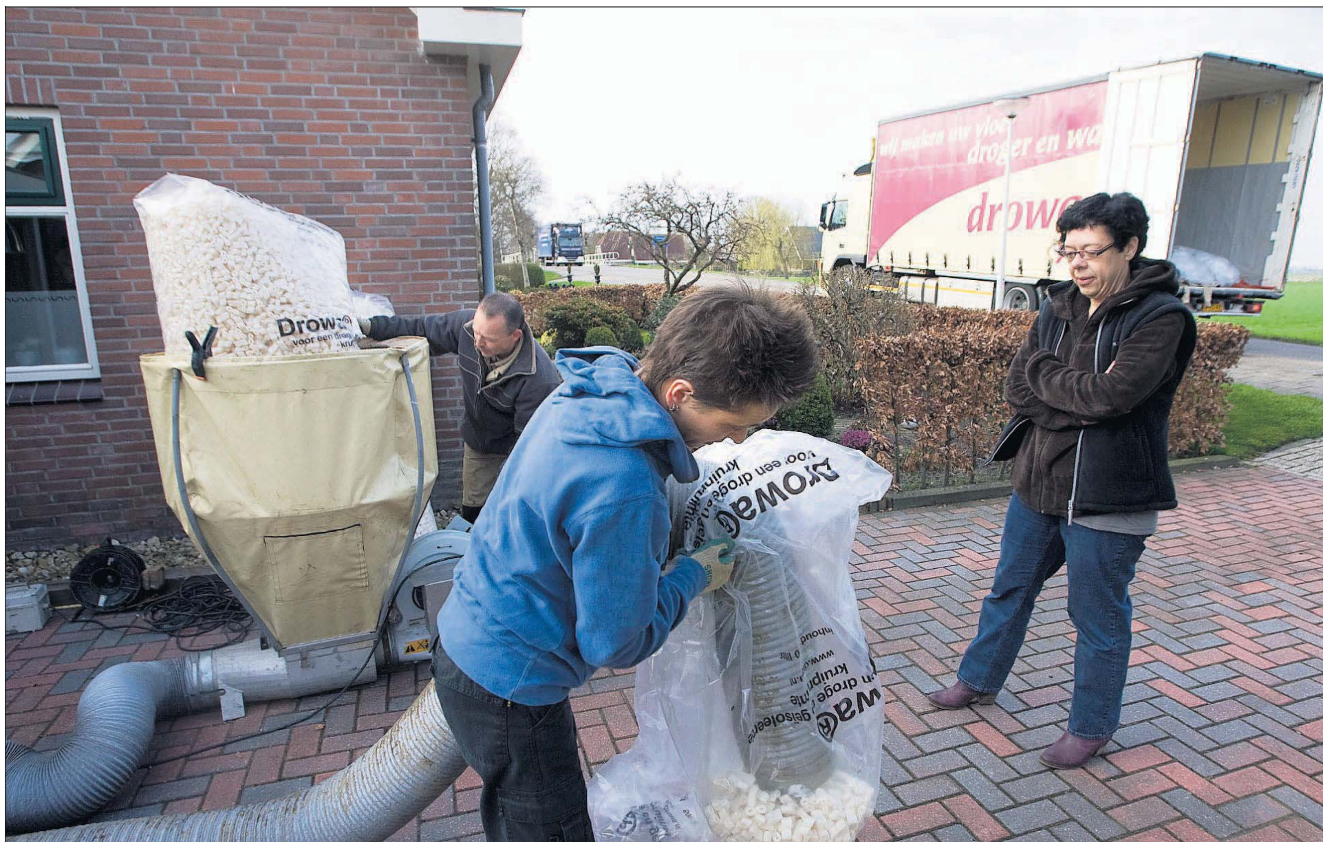
Milly van der Meulen analyseert de aanpak van Siebren Palma en Wilma Bandstra. Ze brengen isolatiechips aan in een kruipruimte van een woning in Terkaple. Foto LC/Jan de Vries
